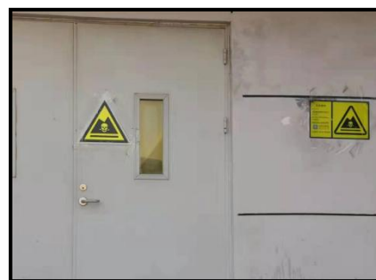
现有工程危废暂存间 1
